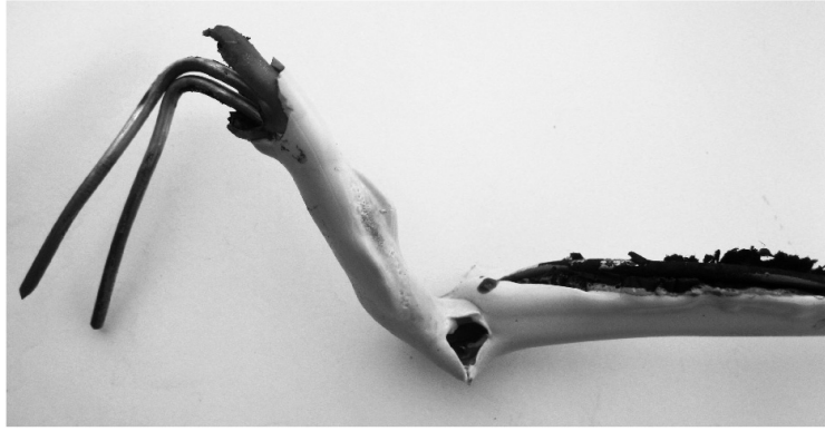
Рис. 6. Внешний вид фрагмента термически поврежденного провода марки ПНП 2 \times 2.5 с ПВХ изоляцией при параллельном включении его двух сплошных круглых медных жил общим сечением S_1 \approx 5 \text{ мм}^2 в сильноточную разрядную цепь мощного высоковольтного генератора ГИТМ-10/350 [17] после протекания по ним аperiodического импульса тока 17/335 мкс искусственной молнии при I \approx 83.8 \text{ кА} , \delta_{1\text{max}} \approx I/S_1 \approx 16.8 \text{ кА/мм}^2 , \tau_f \approx 17 \text{ мкс} , t_{\text{max}} \approx 27 \text{ мкс} , \tau_p \approx 335 \text{ мкс} , k \approx 1.088 , J \approx 1.74 \cdot 10^6 \text{ Дж/Ом} и q \approx 39.5 \text{ Кл}
