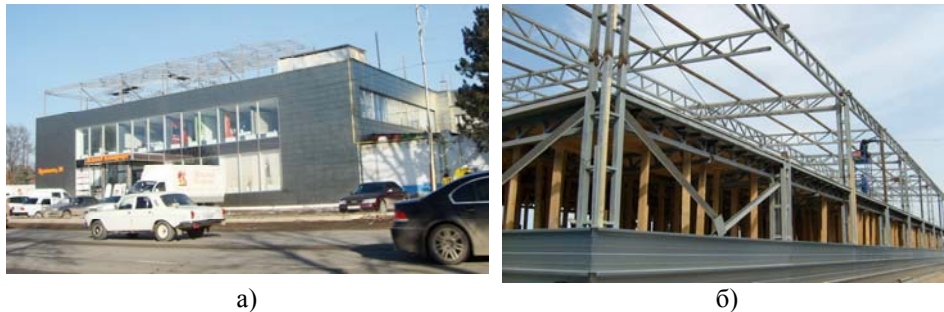
Рис. 4. Общие виды реконструкции трехэтажного здания с ГВЭ из восемнадцати блоков покрытия размерами 6×6 м (а), а также строительства торгового-логистического предприятия с первым этажом из восьми блоков перекрытия размерами 6×6 м и вторым этажом (ГВЭ) из четырех блоков покрытия размерами 12×12 м (б)
