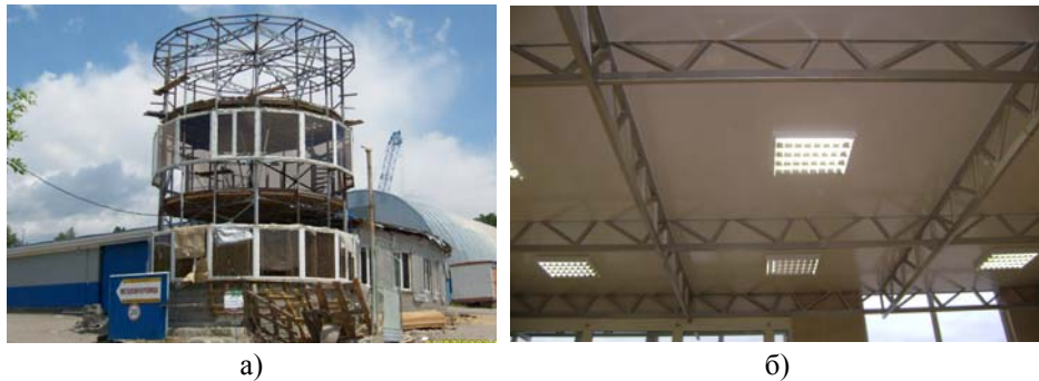
Рис. 1. Снимки трехэтажного модуля при возведении служебного строения (а) и блока перекрытия в интерьере офисного здания (б)
