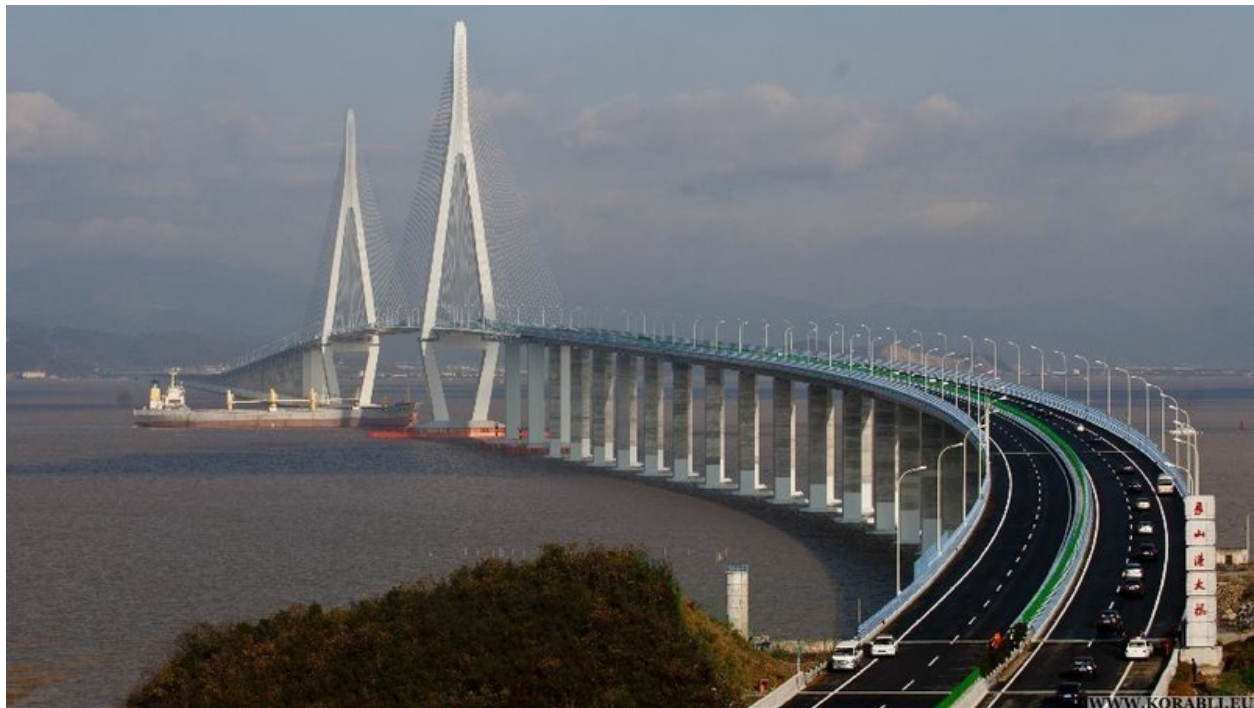
Рис. 1. Міст Цзиньтан в провінції Чжоушань (КНР)
