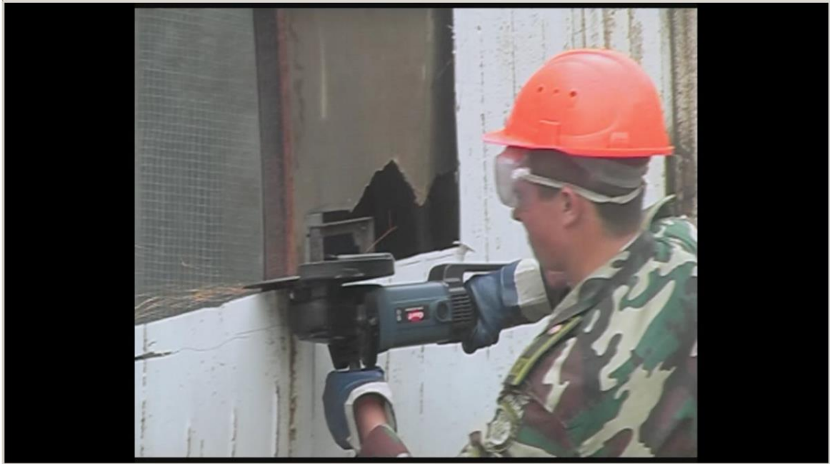
Рисунок 3.26–Виготовлення додаткового отвору для евакуації пасажирів
