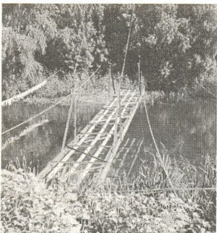
Монтаж аэрационного модуля на р. Лопань
