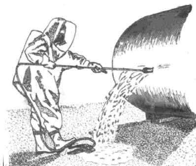
Рис. 7.5 – Затискання пробойни пневматичною заглушкою
