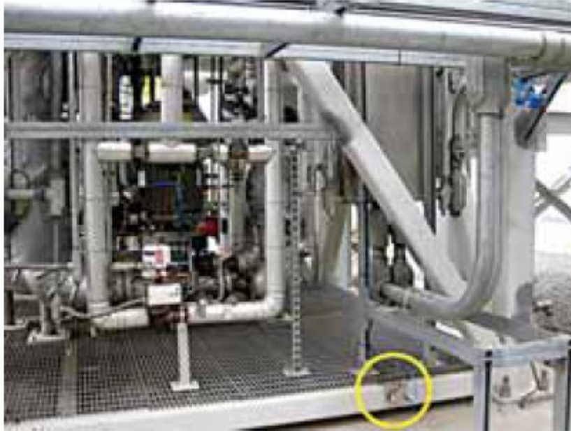
Рисунок 1 – Закріплений п'єзодатчик вібрації Volture на коливній платформі [1]
