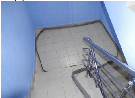
Рисунок 2 – Создание резерва рабочей линии на лестничной площадке
