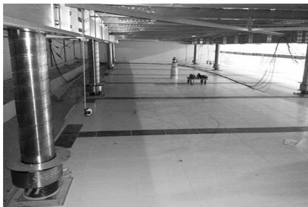
Рисунок 3 Размещение спиралифта под дном бассейна
