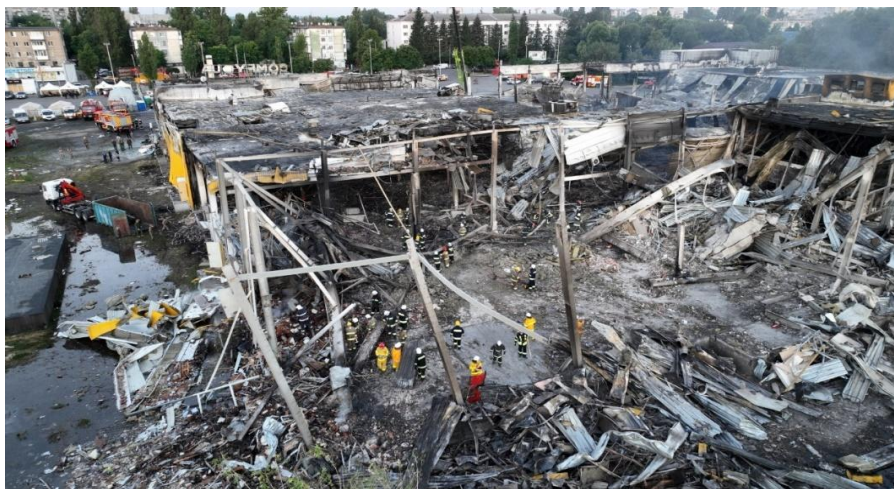
Рисунок 2 - Розбір завалів будівельних конструкцій ТЦ «Амстор» (м. Кременчук) після ракетного обстрілу
