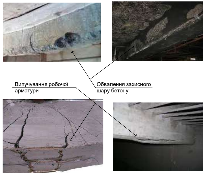
Рисунок – 1.7. Наслідки впливу високих температур на залізобетонні ригелі та балки
