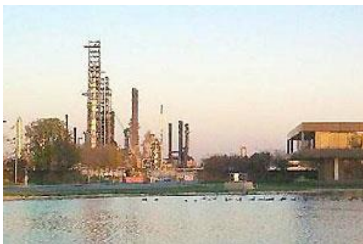
Рисунок 2.9 – Установа каталітичного риформінгу з безперервною регенерацією каталізатора. Реактори розташовані на етажерці вертикально, один над одним
