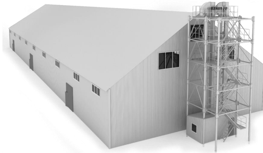
Рисунок 1.1 – Склад підлогового зберігання на плоскому днищі
