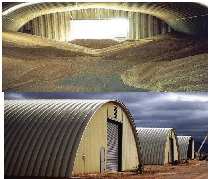
Рисунок 4.1 – Зерносховища горизонтального зберігання на базі безкаркасних арочних будівель з оцинкованої сталі
