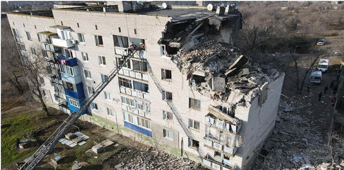
Рис. 4. Руйнування будинку внаслідок вибуху газу
