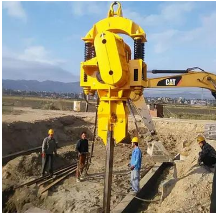
Рисунок 1 - Вібродарний метод заглиблення палі.
