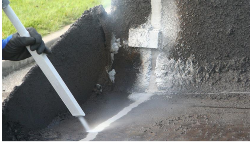
Рисунок 1. Очищення сухим льодом внутрішніх поверхонь резервуара
