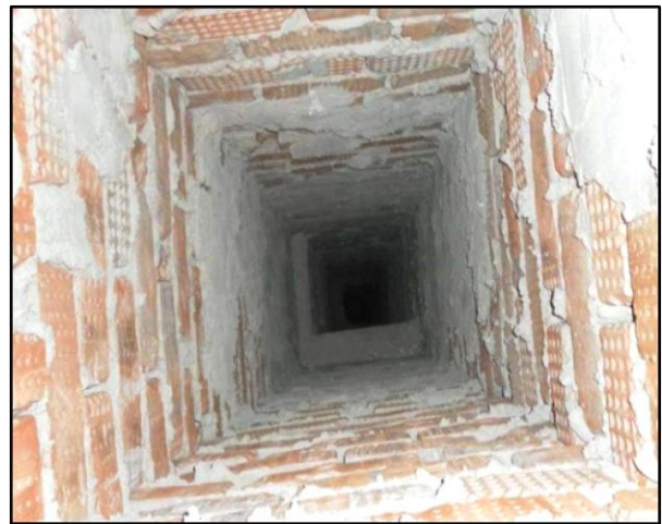
Рис. 14.10 – Шахта димовидалення із цегли
