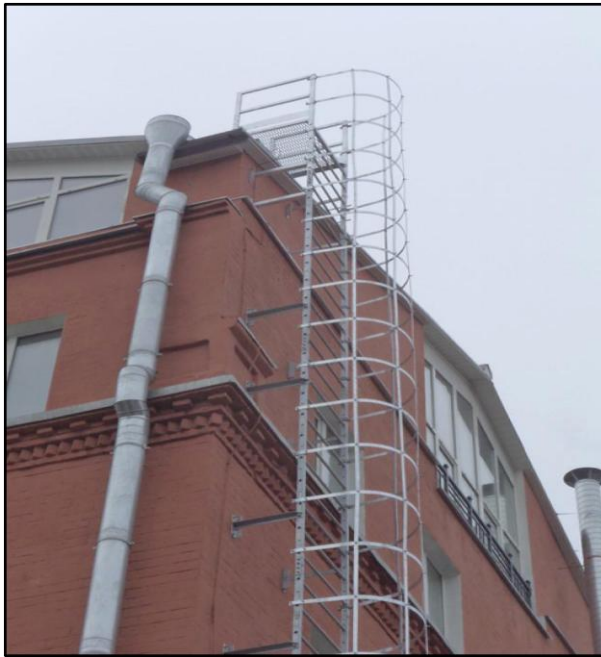
Рис. 3.8 – Зовнішні пожежні драбини типу П1
