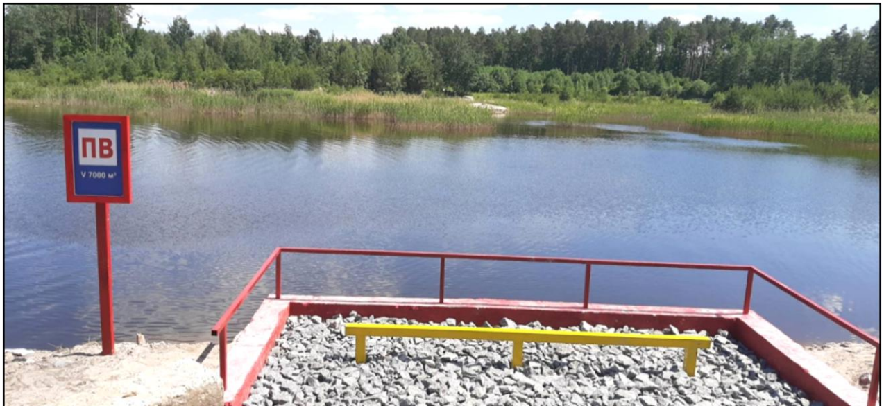
Рис. 6.5 – Укращений гравієм майданчик для забору води пожежними автомобілями
