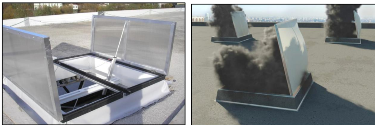
Рис. 13.7 – Димові люки у покритті над сценою
