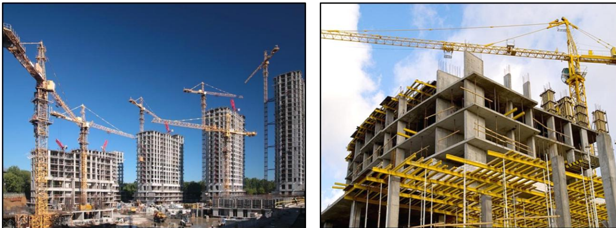
Рис. 1.1 – Об'єкти нового будівництва
