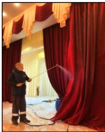
Рис. 13.15 – Нанесення вогнезахисних речовин на сценічну коробку та занавіс
