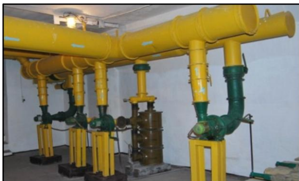
Рис. 20.1 – Вигляд фільтровентиляційного приміщення
