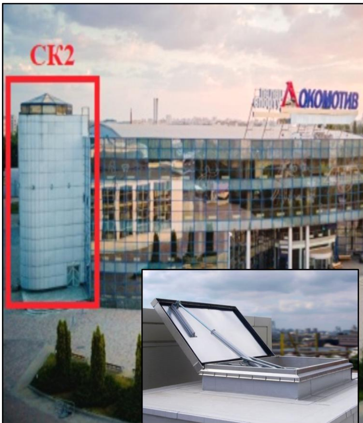
Рис. 3.3 – Зображення звичайної сходової клітки типу СК2
