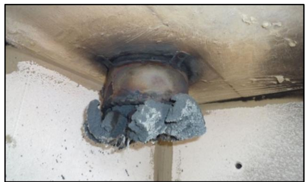
Рис. 21.4 – Протипожежна муфта після спрацювання
