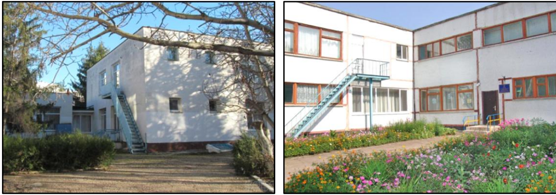
Рис. 16.3 – Другий евакуаційний вихід з другого поверху будівлі закладів дошкільної освіти через сходи типу СЗ
