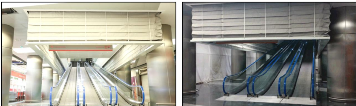
Рис. 21.11 – Зовнішній вигляд протидимових завіс
