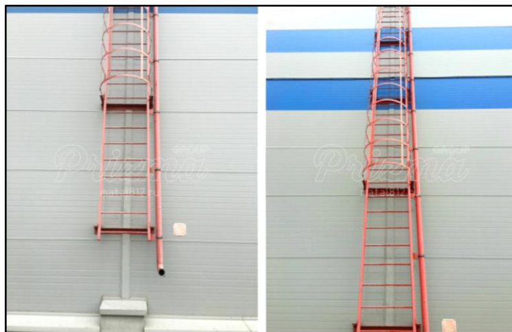
Рис. 7.1 – Зовнішні пожежні драбини обладнані стояками сухотрубами діаметрами 80 мм
