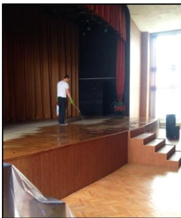
Рис. 13.15 – Нанесення вогнезахисних речовин на сценічну коробку та занавіс
