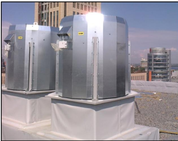
Рис. 14.9 – Вентилятор димовидалення даховий
