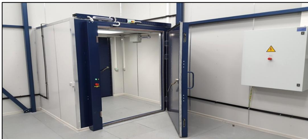
Рис. 8.2 – Тамбур-шлюз з постійним підпором повітря
