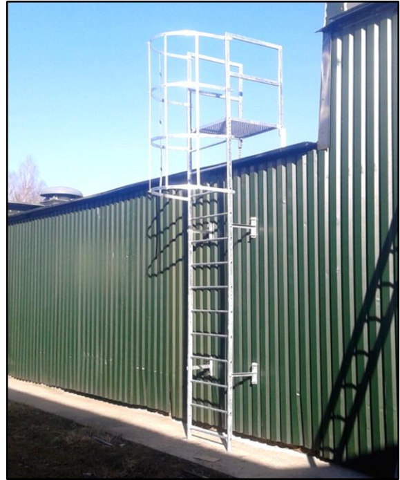
Рис. 8.9 – Зовнішня металева драбина у місці перепаді висот на покрівлі
