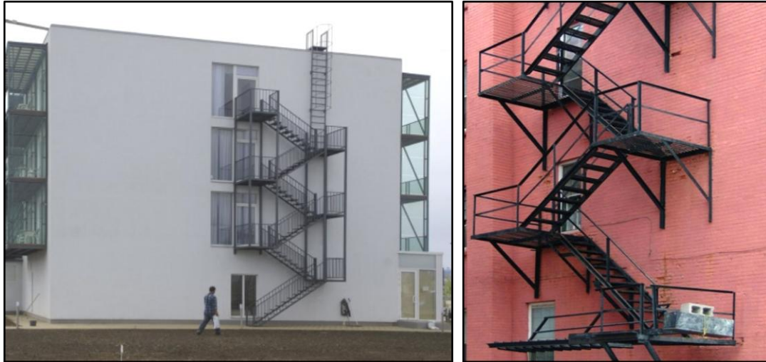
Рис. 14.8 – Вихід з житлового будинку на сходи типу СЗ
