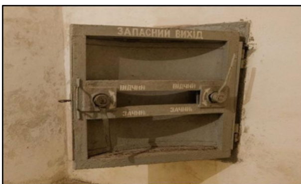
Рис. 20.4 – Аварійний тунель з люком
