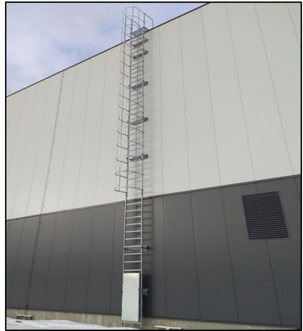
Рис. 3.8 – Зовнішні пожежні драбини типу П1
