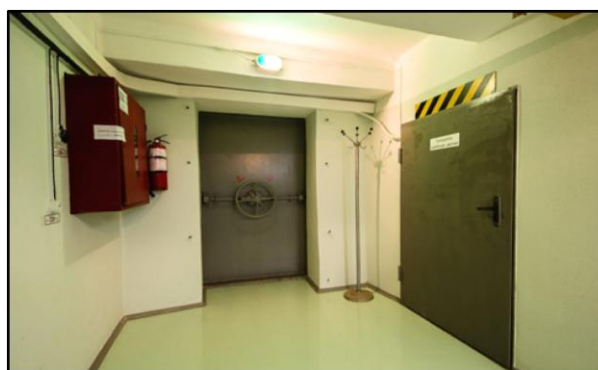
Рис. 20.5 – Захисно-герметичні двері
