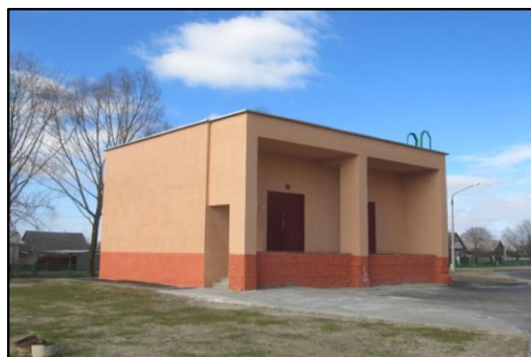
Рис. 17.2 – Централізований пункт зберігання і розподілу кисню
