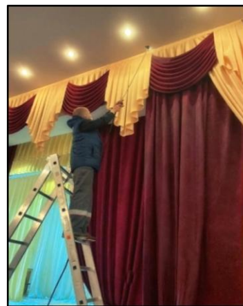
Рис. 13.15 – Нанесення вогнезахисних речовин на сценічну коробку та занавіс
