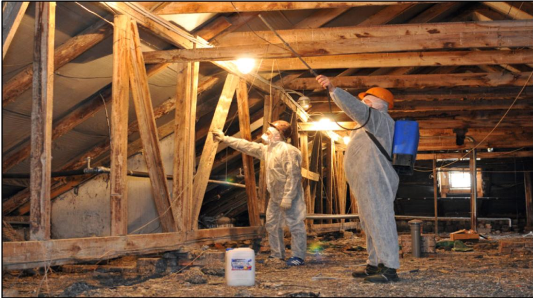
Рис. 2.9 – Оброблення засобами вогнезахисту дерев'яних елементів горищних покриттів
