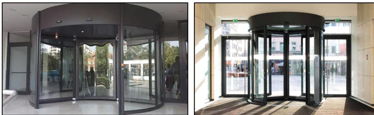
Рис. 15.5 – Обертювальні двері з торговельних зал
