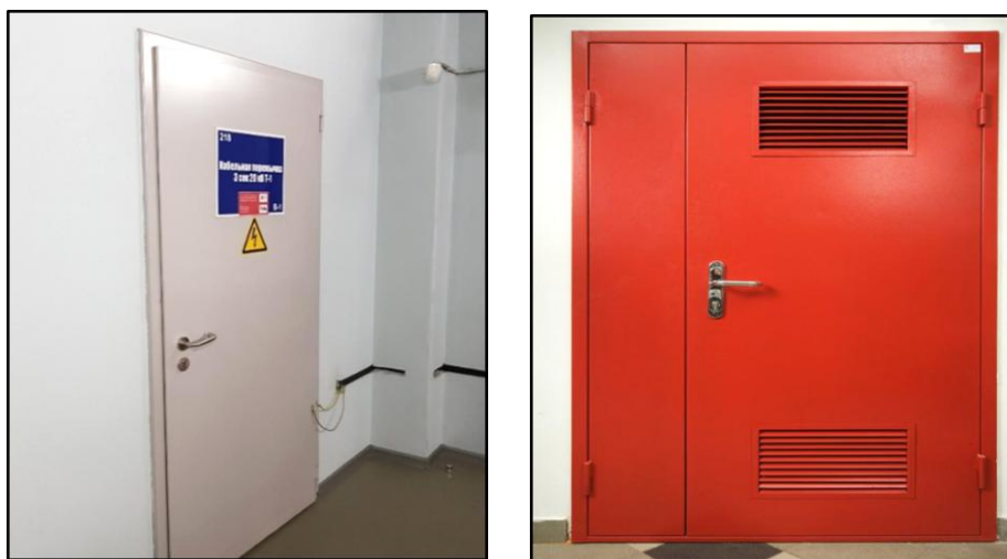
Рис. 11.14 – Двері протипожежні для приміщень електрощитових
