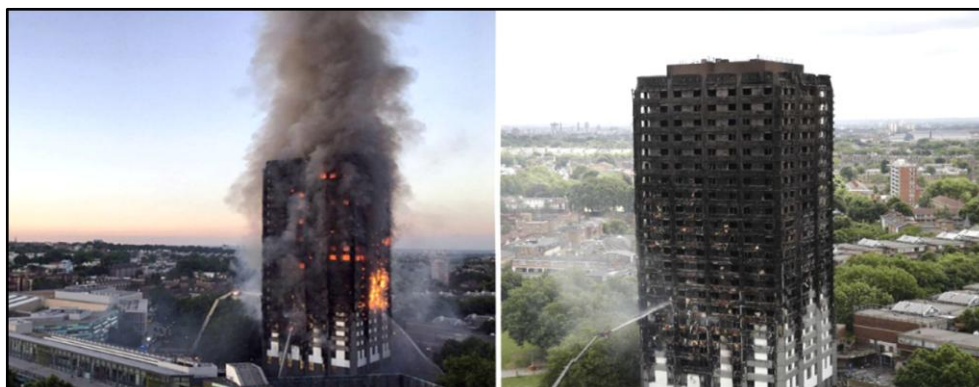
Рис. 2.1 – Пожежа в житловому будинках де зовнішня поверхня облицювання зовнішніх стін будинку була виконана з використанням горючих матеріалів
