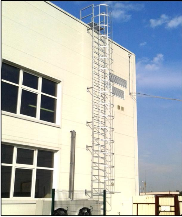
Рис. 8.8 – Вихід на покрівлю по зовнішній металевій драбині
