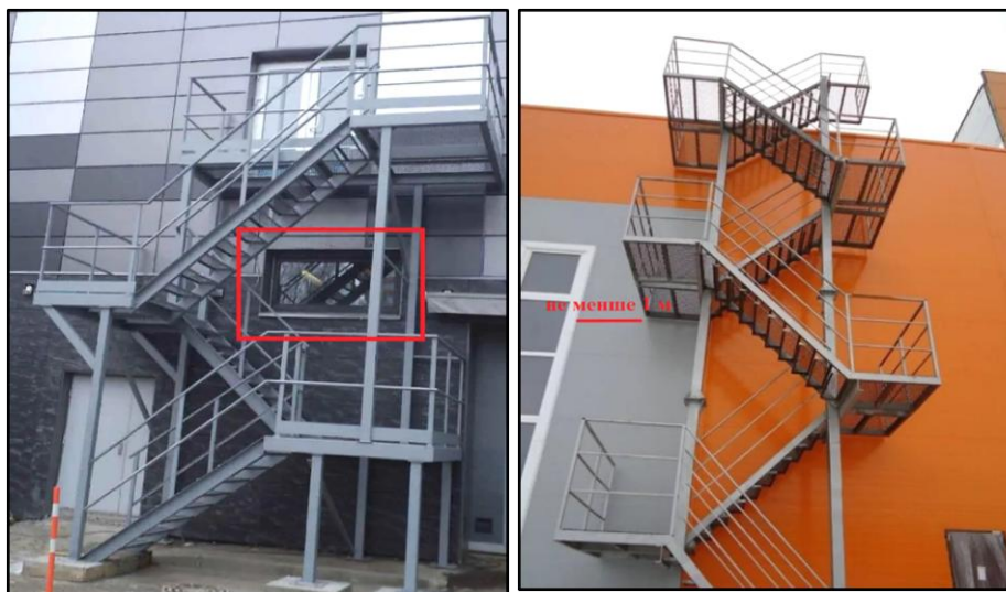
Рис. 4.3 – Варіанти не вірного та вірного виконання зовнішніх пожежних драбини
