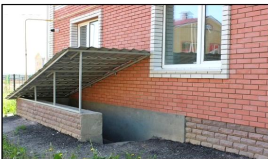
Рис. 11.11 – Виходи з підвалів безпосередньо назовні
