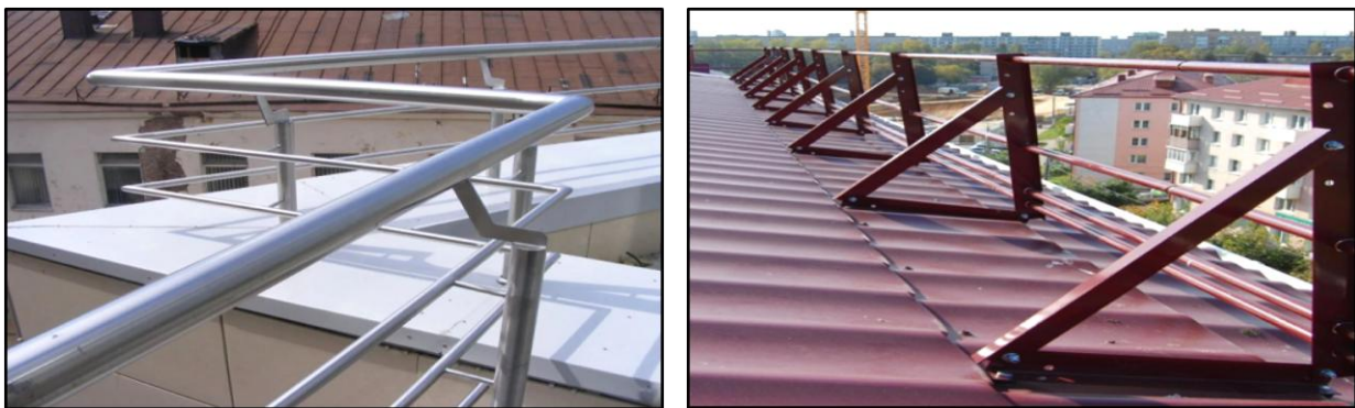
Рис. 4.5 – Зображення захисних огорож за периметром покрівель будинків
