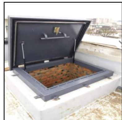
Рис. 2.6 – Протипожежний люк
