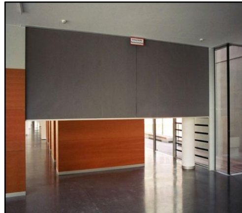
Рис. 2.3 – Протипожежна завіса
