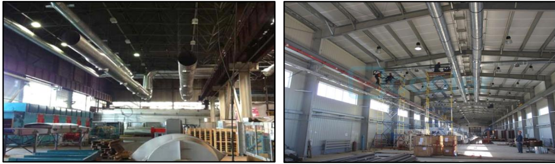
Рис. 21.9 – Аварійна вентиляція виробничих приміщень
