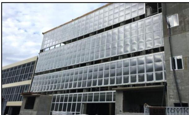
Рис. 9.3 – Легкоскидні конструкції складських будівель категорій А, Б
