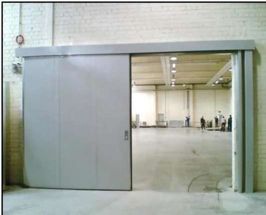
Рис. 2.2 – Протипожежні ворота
