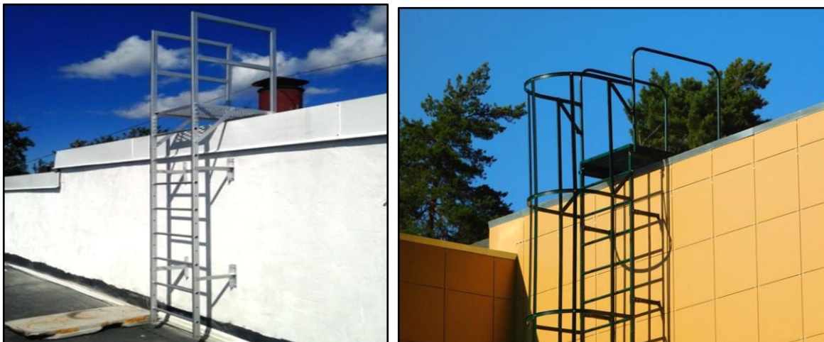
Рис. 4.2 – Влаштування зовнішніх пожежних драбин типів П1 у місцях перепаду висот покрівель більше ніж 1 м (не більше 20 м)
