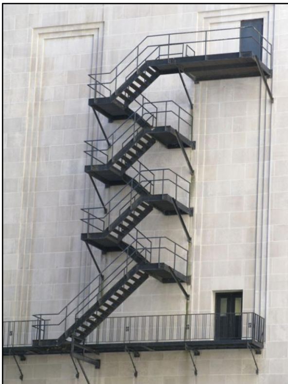
Рис. 3.9 – Зовнішні пожежні драбини типу П2
