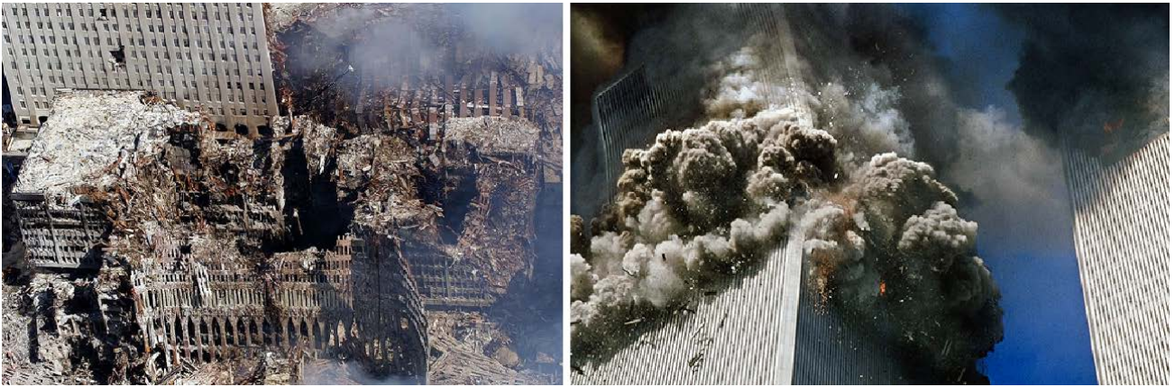
Рис. 2 11 вересня 2001 року США. Руйнування світових торговельних центрів в результаті терористичного акту та ефекту прогресуючого обвалення
