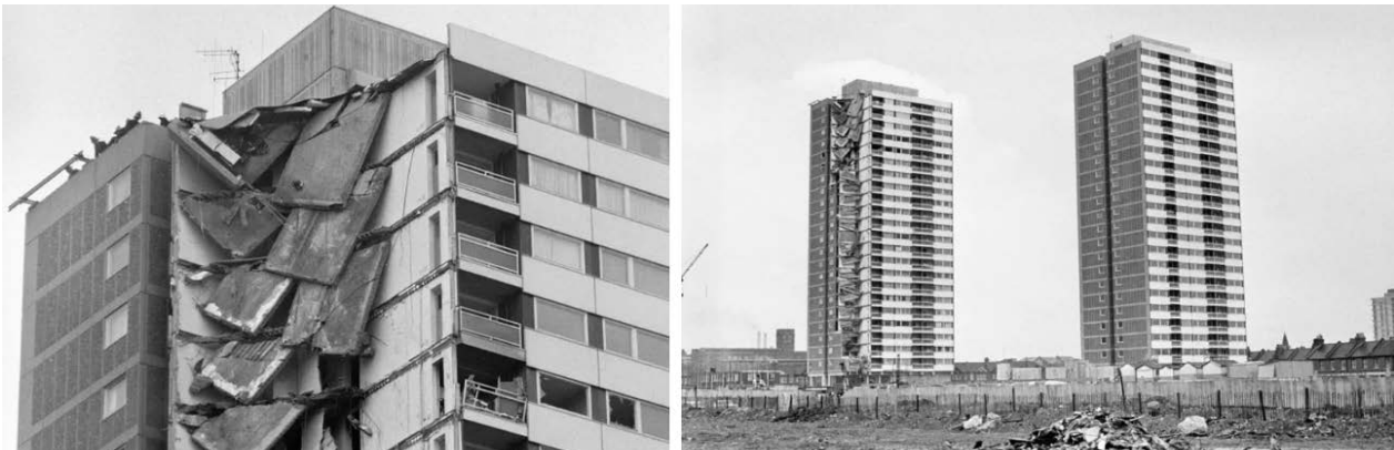
Рис. 1. 16 травня 1968 рік, Лондон, наслідки ефекту прогресуючого обвалення конструкцій житлового будинку після вибуху побутового газу в одній із квартир
