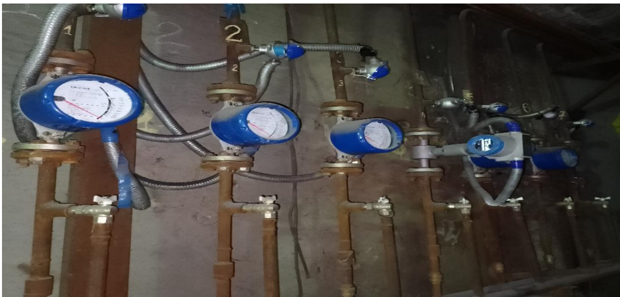
Рисунок 3 – Схема розташування ротаметрів та датчиків температури на зворотньому контурі охолодження сцинтиляційних детекторів.
