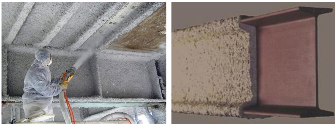
Рис.1. Процес проведення вогнезахисту металевих конструкцій та захищена вогнезахисним шаром металева конструкція
