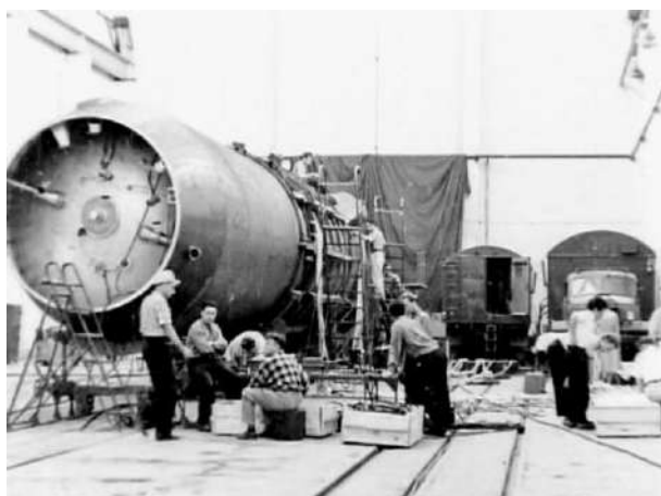
Рис. 4. Підготовка ракети Р-16 в монтажно-випробувальному корпусі на Байконурі
