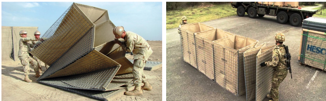
Рис. 2. Встановлення комплекту «Концептейнер» (Concertainer) на задалегідь підготовленому місці.
