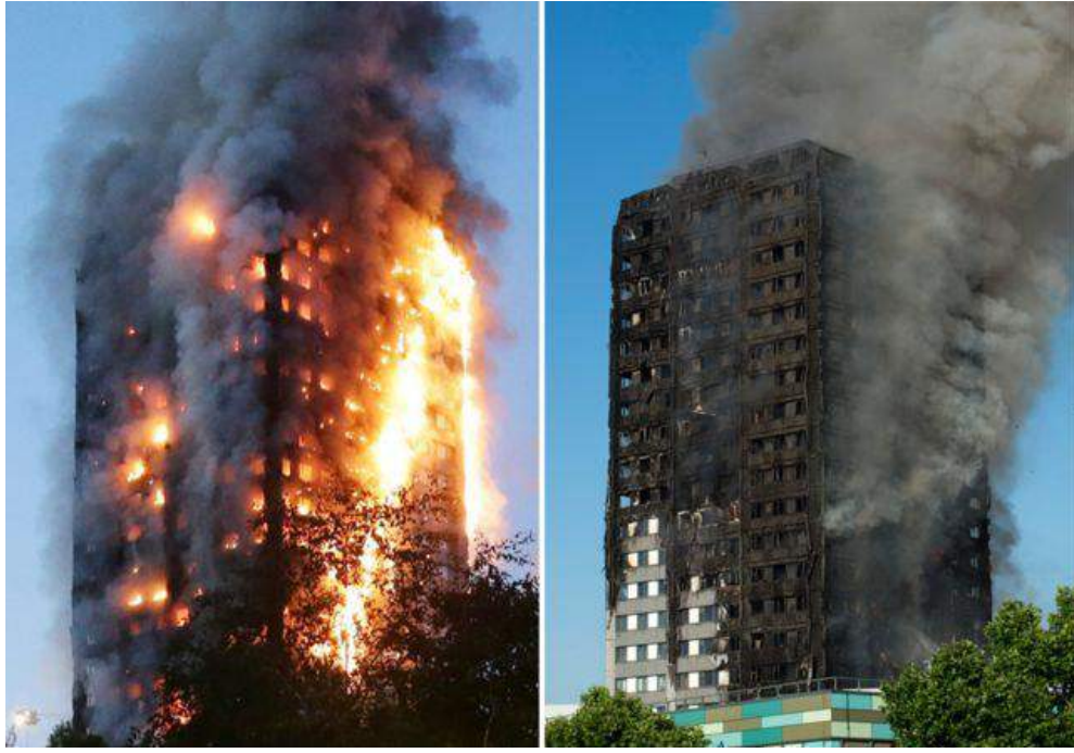
Рис. 1. Пожежа в будівлі Гренфелл-Тауэр, Лондон (Великобританія).
